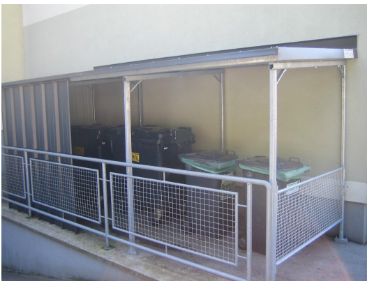
Anfertigen eines Müllports in Waidhofen/ Ybbs – Blechverkleidung ausgeführt von Herbst Dach, Ybbsitz
