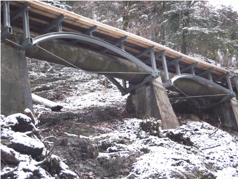
Innovative neue Tragkonstruktion als Steinschlagschutz für die Druckrohrleitung der EVN in Ybbsitz/Nothberg Vom geistig-schöpferischen Inhalt kann dieses Werk mit der Erlebnisbrücke leicht mithalten!
