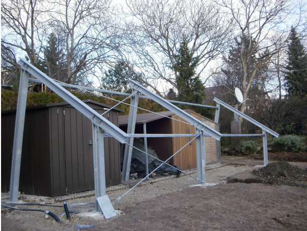
Unterkonstruktion für Photovoltaik-Anlage – privater Auftraggeber in Hinterbrühl Große Konzerne reden viel über alternative Energien – wir machen es!
