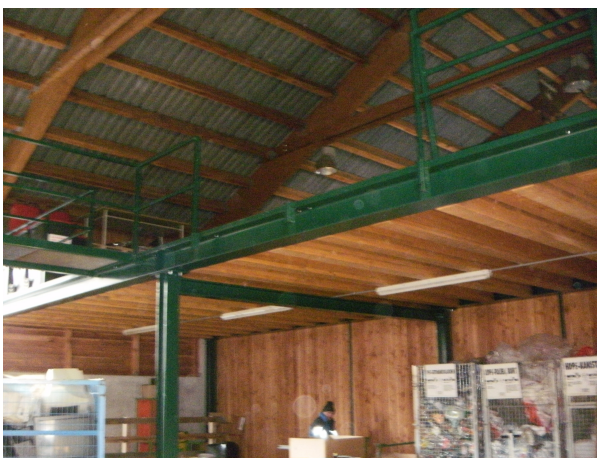
Sammelzentrum Ybbsitz – Zwischendeckenkonstruktion, Auftraggeber Bgm. Hofmarcher
